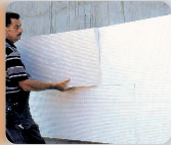
Bei der **W-MS** steht der Abdichtungs- und Mauerschutz von erdberührten Bauteilen im Vordergrund. Zusätzlich verfügt die EPS-Platte über Drainkanäle zur Ableitung von Wasser.
