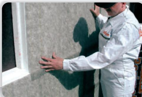
**W-WB** ist eine langzeitstabile Wärmebrückendämmplatte mit stumpfen Kanten und strukturierter, verputzbarer Oberfläche.
