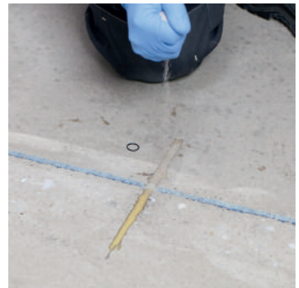
Oberfläche glatt abziehen und bei Bedarf mit Quarzand 0,3 - 0,8 mm voll deckend abstreuen.
