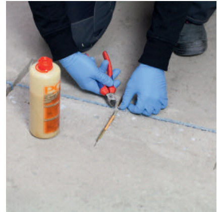
PCI Apogel® Dübel oder Estrichklammern in die Nut einlegen.
