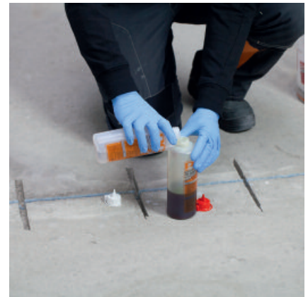
Wenn die zu vergießenden Fugen oder Nuten vorbereitet sind die beiden Komponenten von PCI Apogel® SH zusammenschütten.
