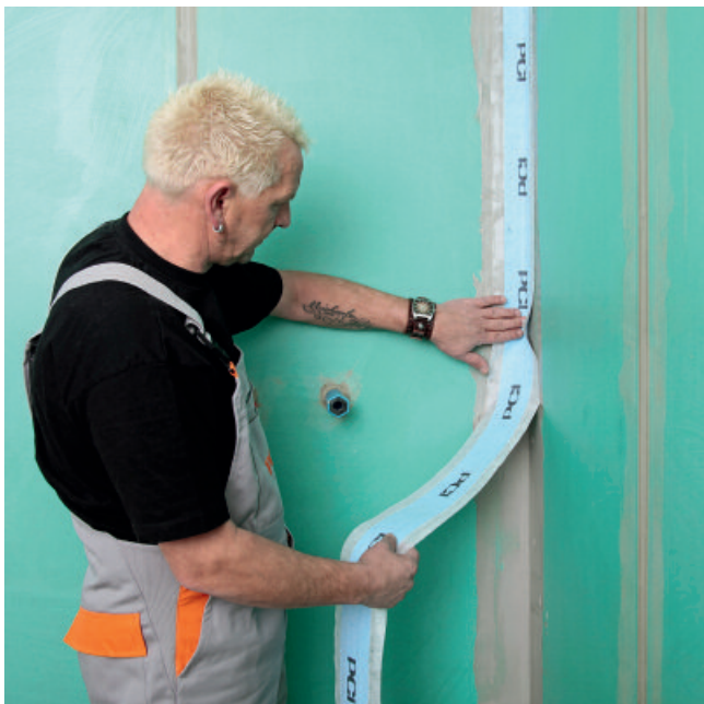
3. PCI Pecitape 120 mit PCI Lastogum (grau) in Eckfugen und Boden-Wand-Anschlüsse einkleben.
