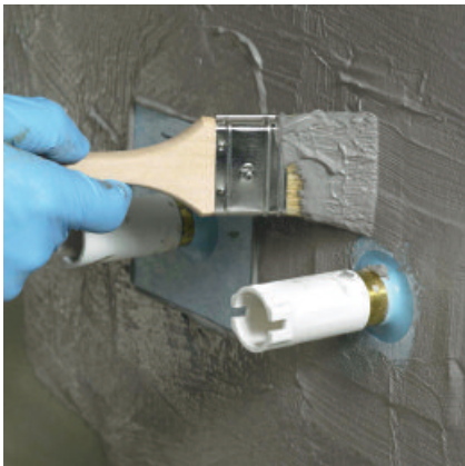
Die Dichtmanschetten PCI Pecitape 10 x 10 ordnungsgemäß einbetten.
