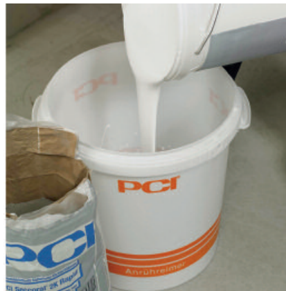
PCI Seccoral 2K Rapid flüssig in ein sauberes Mischgefäß geben.
