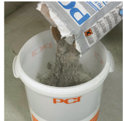
PCI Seccoral 2K Rapid Pulver dazugeben.
