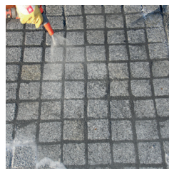
Mit Wassersprühstrahl und
