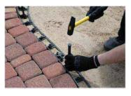
Die Beetumrandungen werden mit Nägeln am Untergrund befestigt: a) aus Kunststoff für weichen Untergrundtypen (Rasen, Ackerland usw.),
