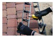
Durch Einschneiden des unteren Kunststoffstreifens der Beetumrandung können Bögen geformt werden.
