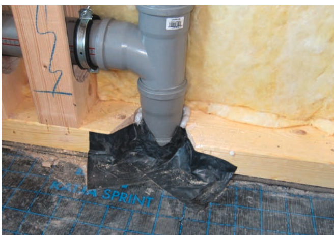
Schwierigkeit: Einbindung der Dampfsperre
