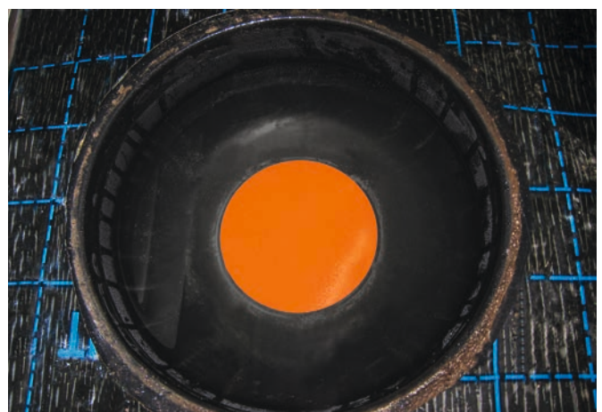
Einfaches Einbinden der Dampfsperre über Klebeflansch
