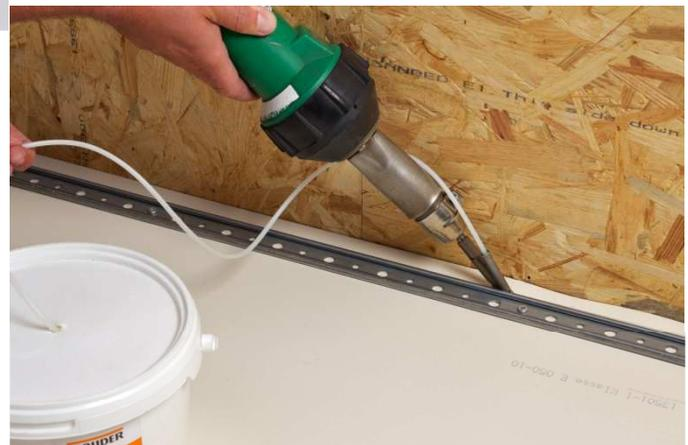
Verschweißung hinter der Befestigungsschiene
