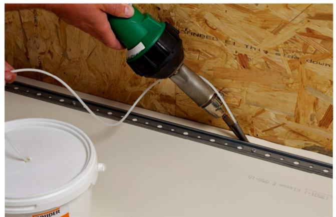
Verschweißung hinter der Befestigungsschiene
