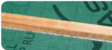
1. Folie abziehen und Bahnen verkleben.
