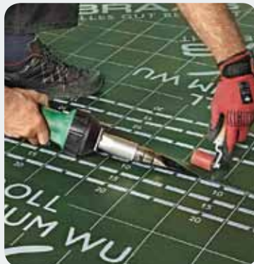
Sichere Verschweißung mit einem Heißluftföhn.
