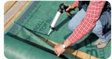
3. Verklebung von Querstößen und aufgehenden Bauteilen.
