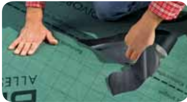
1. Folie abziehen und Bahnen verkleben.
