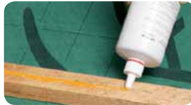
2. Divoroll Dichtmasse auf die Konterlatte auftragen.
