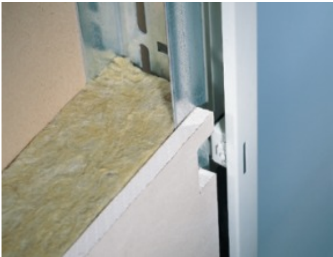
Einbausituation Profil 23/0045
