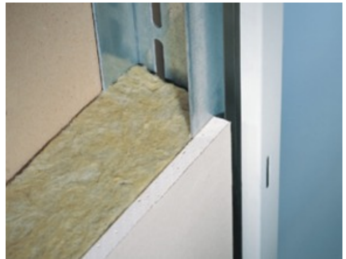
Einbausituation Profil 23/1545
