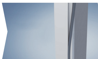
Mitgeliefertes Dichtungsprofil in die Zargennut einlegen
