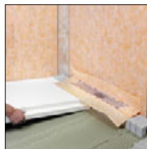
zu 3. Ausgleichsboard ebenflächig verlegen
