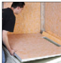
zu 3. Gefälleboard unter den Rand des Rinnenkörpers schieben
