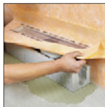
zu 2. Rinnenkörper einsetzen
