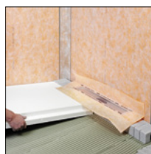
zu 3. Ausgleichsboard ebenflächig verlegen
