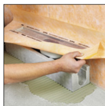
zu 2. Rinnenkörper einsetzen
