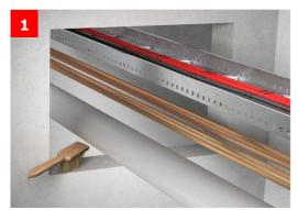
Reinigung der Einbauöffnung. Ermittlung der Bauteilmaße und der Lage bzw. Abmessungen der abzuschottenden Installationen. (siehe Zulassung: ABZ Z-19.15-1870)
