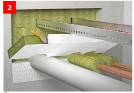
Übertragung der Maße auf die Mineralwolleplatte. Hierbei ca. 3 mm zugeben, um einen strammen Sitz im eingebauten Zustand zu gewährleisten. Je nach Lage und Geometrie der Installationen sind einzelne, möglichst große Passstücke anzufertigen. Zuschnitt der Mineralwolleplatten mit Säge oder gezahntem Messer. Probeweise Einpassen in die Bauteilöffnung. Die Beschichtung der Mineralwolleplatten zeigt jeweils zur Raumseite.
