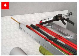
Verschließen von Spalten, Fugen, Zwickeln zwischen Kabeln, Kabeltragekonstruktionen und Mineralwolleplatten bzw. Bauteillaibungen mit dem AESTUVER Spachtel ABL. Bei Kabeltragekonstruktionen aus Stahlblech oder Aluminiumhohlprofilen sind insbesondere die Holme im Bereich der Durchführung mit dem Spachtel zu verschließen (ggf. Profile hierzu anbohren).
