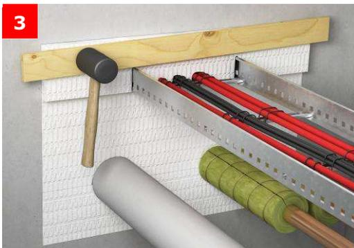
**3** Einstreichen aller Schnittkanten bzw. Stöße der Mineralwolleplatten sowie der Kabeltragekonstruktion und Kabel innerhalb der Abschottung mit der Beschichtung. Vorsichtig die Mineralwolleplatten beidseitig einpassen. Hohlräume mit loser Mineralwolle (Schmelzpunkt > 1000 °C) fest ausstopfen (z.B. mit Hilfe eines Holzstabes).
