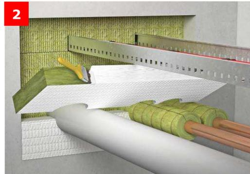
**2** Übertragung der Maße auf die Mineralwolleplatte. Hierbei ca. 3 mm zugeben, um einen strammen Sitz im eingebauten Zustand zu gewährleisten. Je nach Lage und Geometrie der Installationen sind einzelne, möglichst große Passstücke anzufertigen. Zuschnitt der Mineralwolleplatten mit Säge oder gezahntem Messer. Probeweise Einpassen in die Bauteilöffnung. Die Beschichtung der Mineralwolleplatten zeigt jeweils zur Raumseite.
