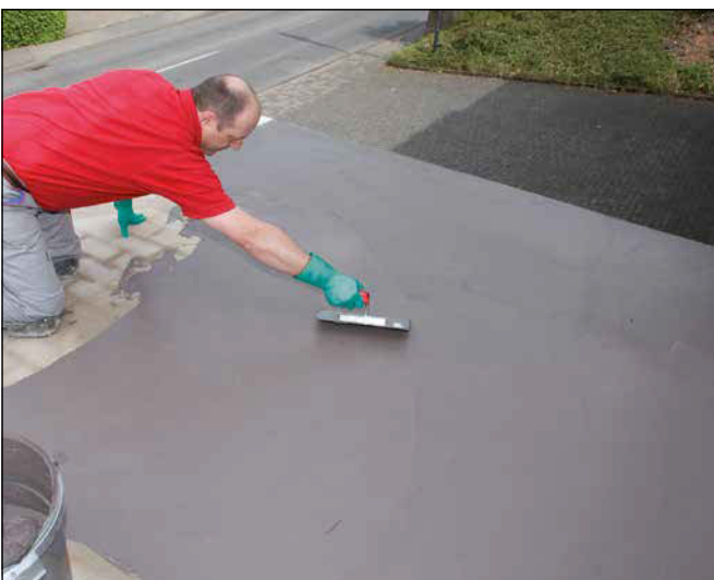
11 Glätten der Sopro TurboDichtSchlämme 2-K mittels Glättkelle.
