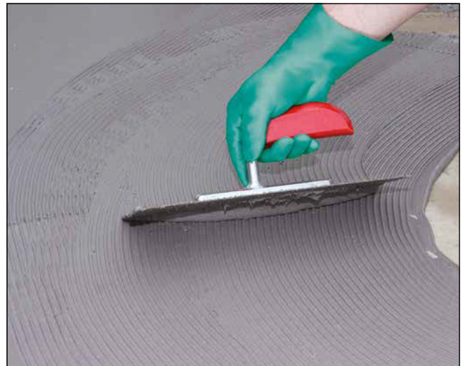
10 Aufziehen der Sopro TurboDichtSchlämme 2-K auf den angefeuchteten bzw. grundierten Untergrund mittels 4 mm-Zahnschpachtel.
