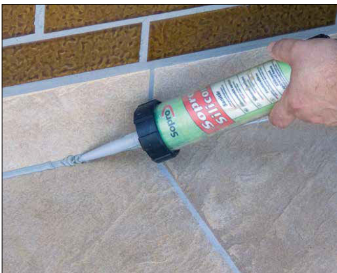
23 Einbringen des Sopro SanitärSilicons in die Anschluss- und Bewegungsfugen.
