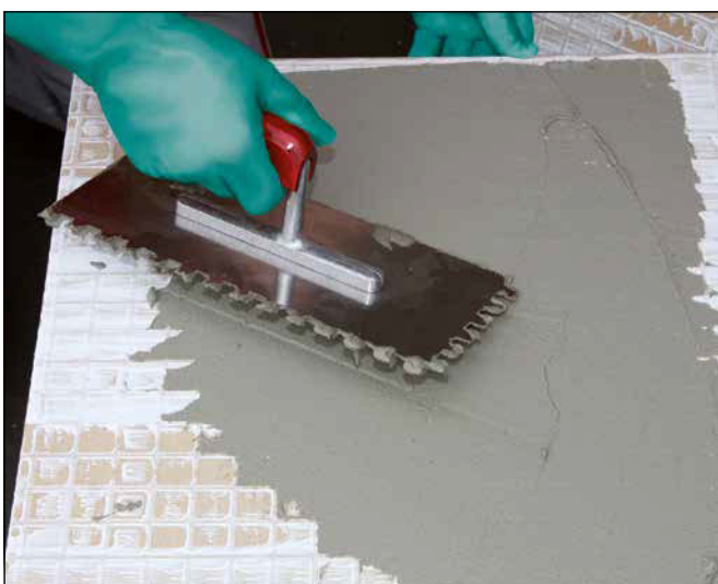
17 Die Anwendung des Buttering-Floating Verfahrens ist von Format und Rückseitenbeschaffenheit der Fliese abhängig und dient der weitgehend vollflächigen Verklebung des Belages.
