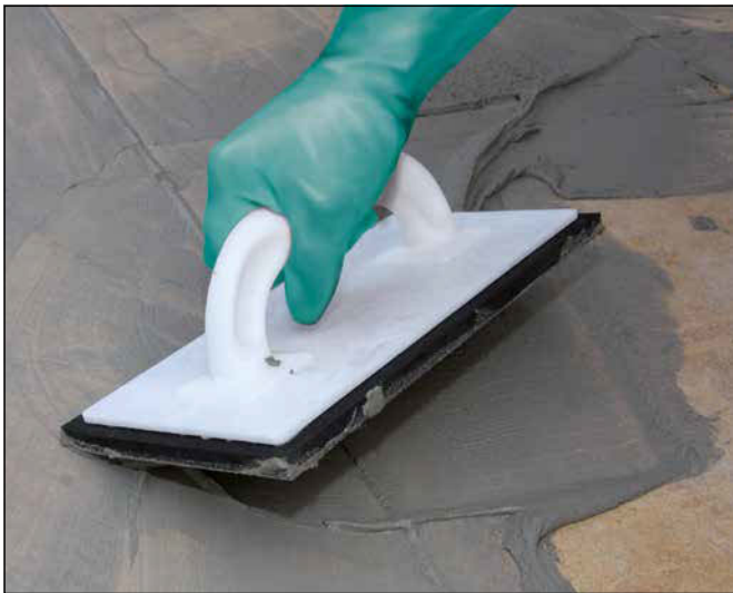
21 Einfügen einer Sopro Fugenmasse (z.B. Sopro DF 10® Design-Fuge Flex oder Sopro FlexFuge FL) nach Erhärtung des Sopro Flexklebers.
