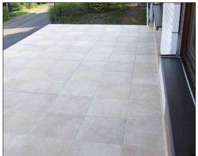
24 Neu verlegter Fliesenbelag auf einem Balkon mit den Sopro Systemkomponenten.
