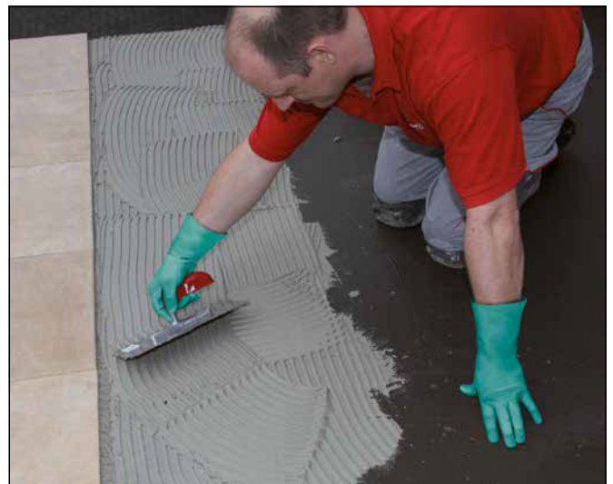
16 Auftragen des zweikomponentigen Flexklebers Sopro megaFlex S2 oder Sopro megaFlex S2 turbo auf die ausgehärtete Abdichtung.
