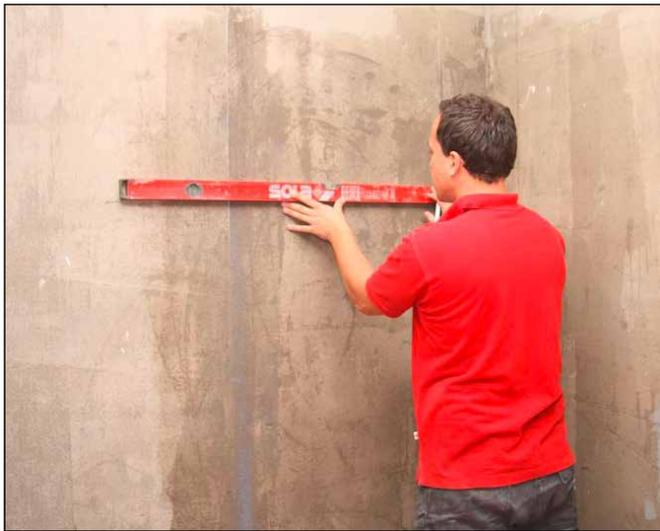
**1** Ausmessen des sauberen, mit Sopro Grundierung vorgrundierten und tragfähigen Untergrundes auf Ebenflächigkeit.
