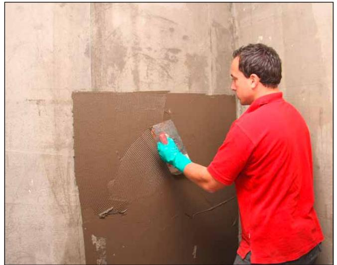
**2** Aufziehen (Zahnung 3×3 bis 4×4) eines Sopro Flexklebers (z. B. Sopro's No.1 (schnell), Sopro FKM® XL) in der entsprechenden Breite der Sopro AEB®.
