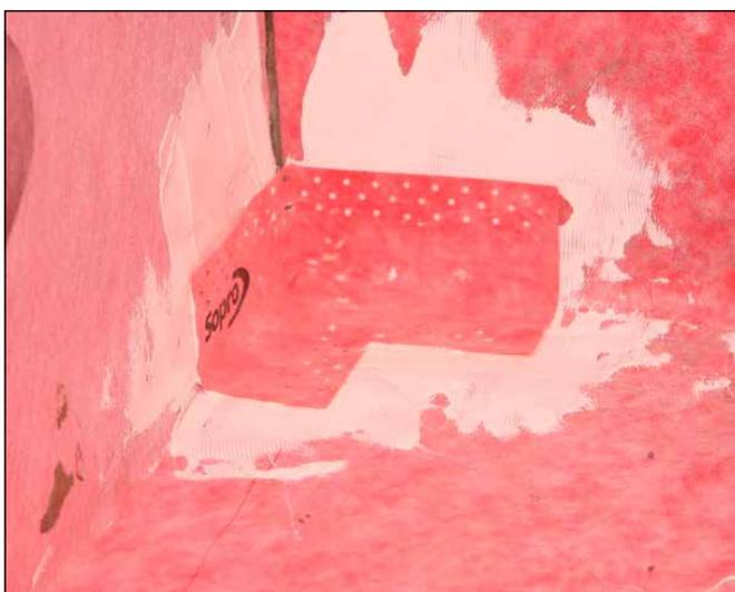
**11** ... Einbau von Sopro AEB® Dichtecke innen.
