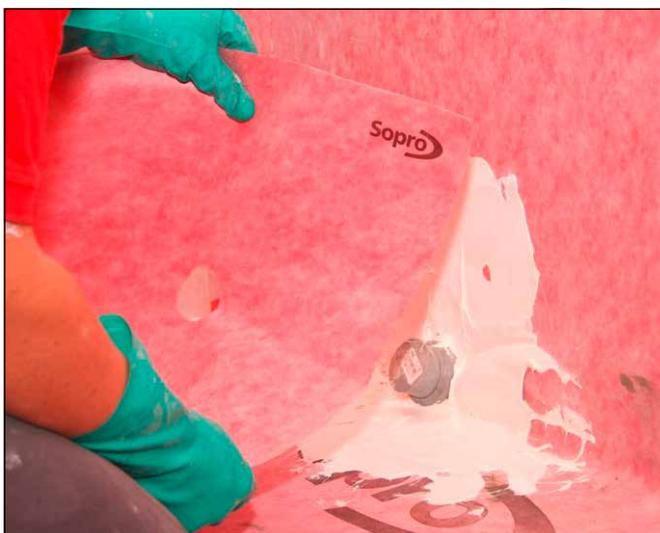
**9** Rohrdurchführungen mit Sopro AEB® Boden- oder Wandmanschette (je nach Größe) und Sopro Racofix® Montagekleber (S) oder Sopro TurboDichtSchlämme 2-K wasserdicht verkleben.
