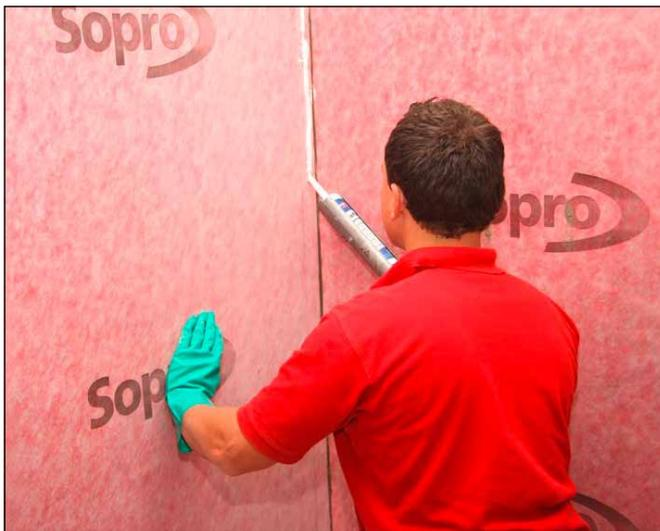
**7** Alternativ können die Bahnen auch stumpf gestoßen und mit Sopro AEB® Dichtband und Sopro Racofix® Montagekleber (S) oder Sopro TurboDichtSchlämme 2-K überklebt werden.
