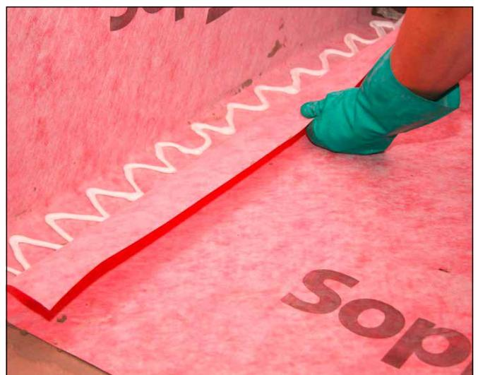
**6** Dazu im Stoßbereich Sopro Racofix® Montagekleber Schlangenförmig auftragen, mit einem fein gezahnten Spachtel flächig verteilen und die Bahn hohlraumfrei andrücken.
