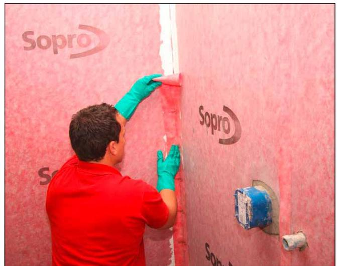
**8** Vollflächiges, hohlraumfreies Einlegen des Sopro AEB® Dichtbandes in den frischen Sopro Racofix® Montagekleber (S), so dass sich der Dichtkleber an den Seiten herausdrückt.
