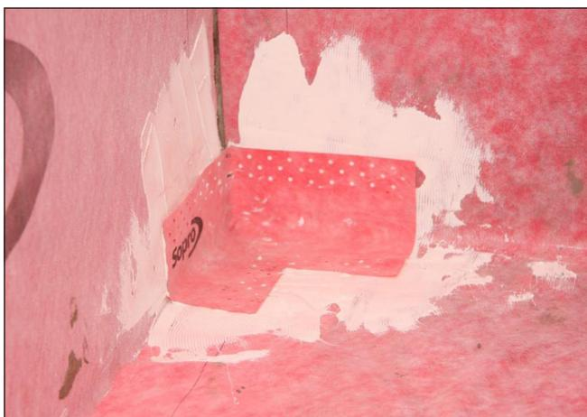
**11** .... Einbau von Sopro AEB® Dichtplatte innen.
