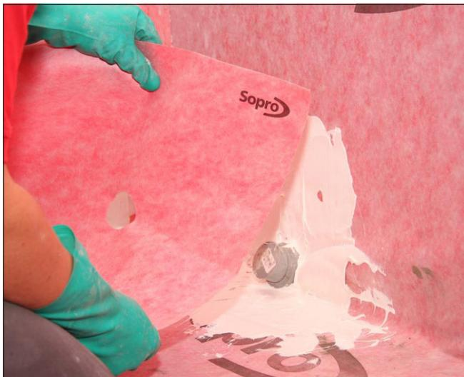
**9** Rohrdurchführungen mit Sopro AEB® Boden- oder Wandmanschette (je nach Größe) und Sopro Racofix® Montagekleber (S) wasserdicht verkleben.
