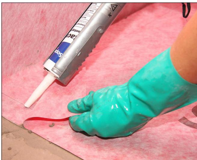
**5** ...mit Sopro Racofix® Montagekleber (S) oder Sopro TurboDichtSchlämme 2-K verkleben.
