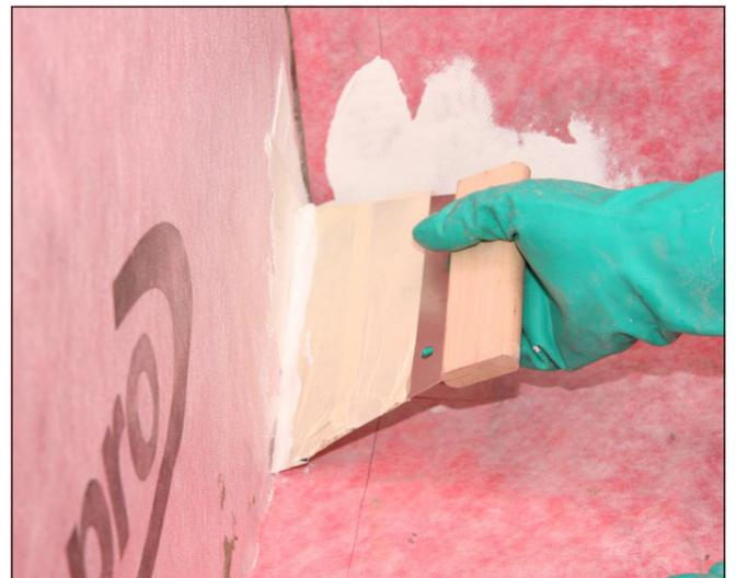
**10** Vorbereitung der Eckbereiche durch Ausspachteln von Sopro Racofix® Montagekleber (S) für den anschließen den ....
