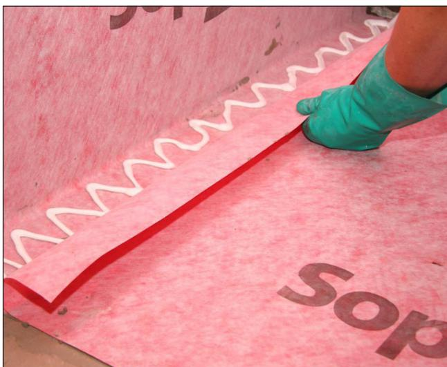
**6** Im Stoßbereich Sopro Racofix® Montagekleber schlangenförmig auftragen, mit einem fein gezahnten Spachtel flächig verteilen und die Bahn hohlraumfrei andrücken.
