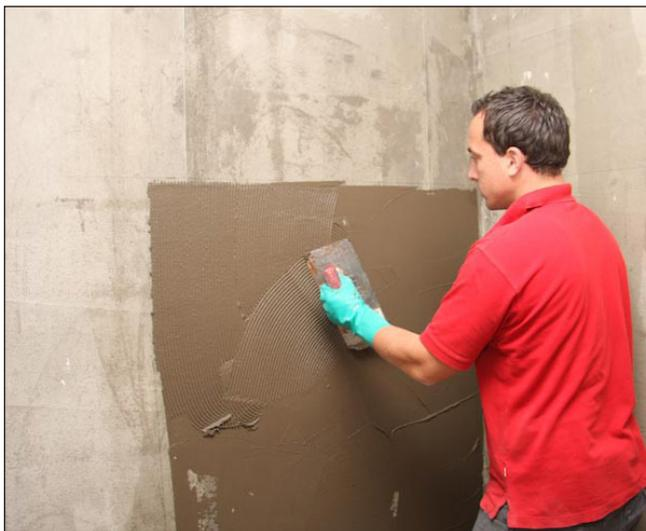
**2** Aufziehen (Zahnung 3x3–4x4) eines Sopro Flexklebers (z.B. Sopro's No.1 (schnell), Sopro FKM® XL) in der entsprechenden Breite der Sopro AEB®.
