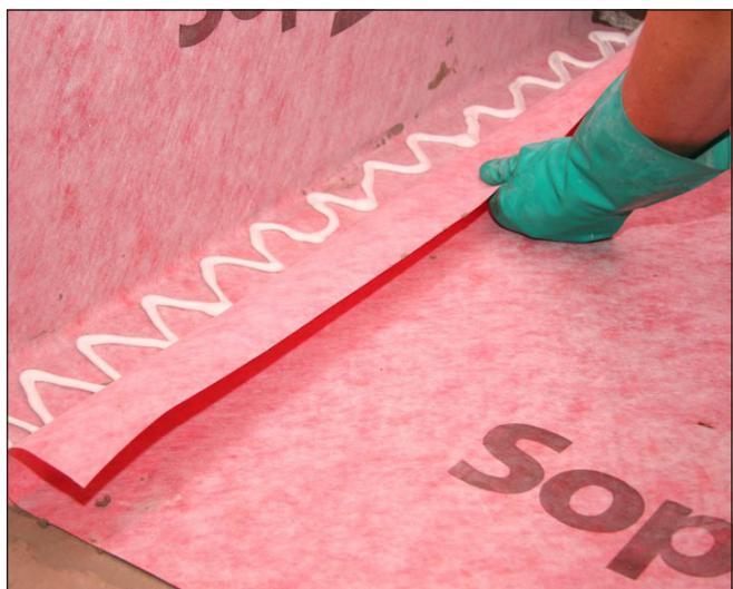
**6** Dazu im Stoßbereich Sopro Racofix® Montagekleber schlangenförmig auftragen, mit einem fein gezahnten Spachtel flächig verteilen und die Bahn hohlraumfrei andrücken.
