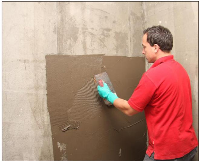
**2** Aufziehen (Zahnung 3×3 bis 4×4) eines Sopro Flexklebers (z.B. Sopro's No.1 (schnell), Sopro FKM® XL) in der entsprechenden Breite der Sopro AEB®.
