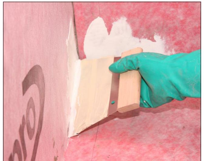
**10** Vorbereitung der Eckbereiche durch Ausspachteln von Sopro Racofix® Montagekleber (S) oder Sopro TurboDichtSchlämme 2-K für den anschließenden ...
