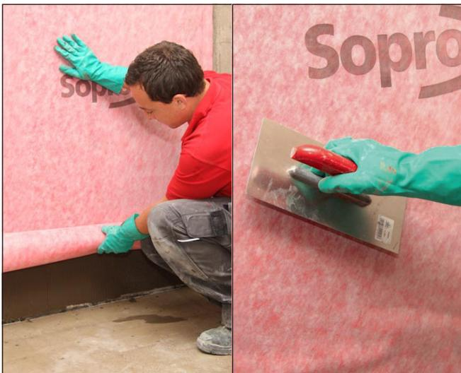
**3** Die passgenau zugeschnittene Sopro AEB® vollflächig in den frischen Sopro Klebemörtel einlegen und mit einer Zahn- oder Glättkelle glatt streichen.
