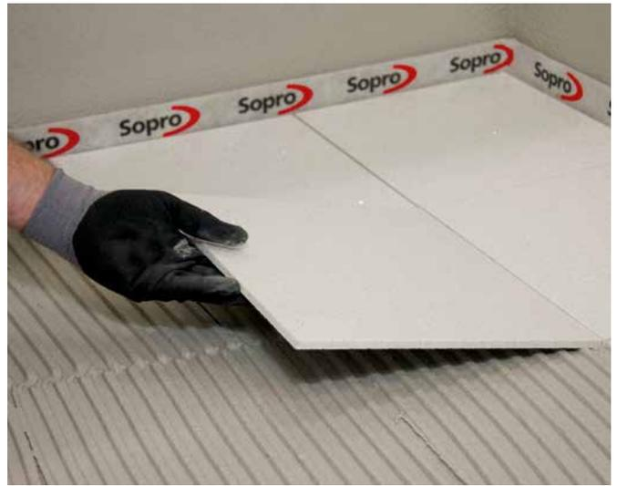
2 Einlegen einer Aggloplatte. Aufgrund der Schnellerhärtung eignet sich Sopro FKM® Silver auch für die Verlegung verformungsempfindlicher Beläge.
