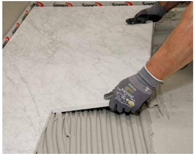
2 Einlegen einer Natursteinplatte. Aufgrund der hellen Farbe eignet sich Sopro FKM® Silver auch für die Verlegung durchscheinender Materialien.
