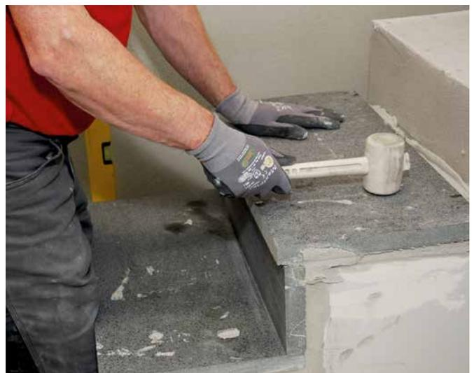
2 Verlegen einer Treppenstufe. Aufgrund der Schnellerhärtung kann eine frühe Belastung erfolgen.
