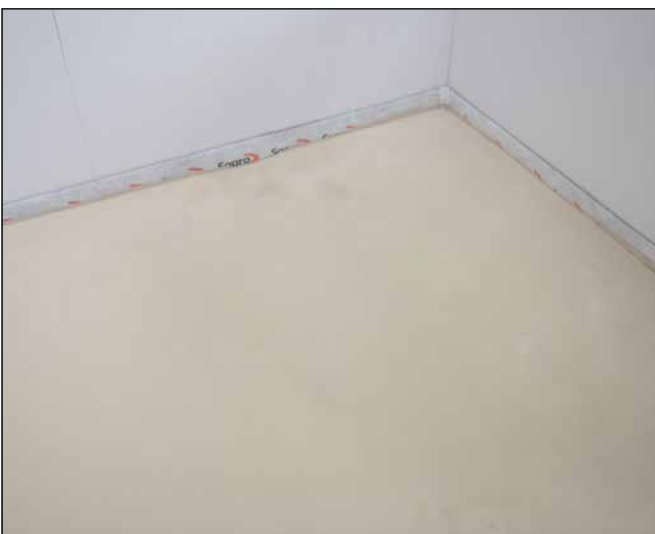
9 Sopro VS 582 im ausgetrockneten Zustand.
