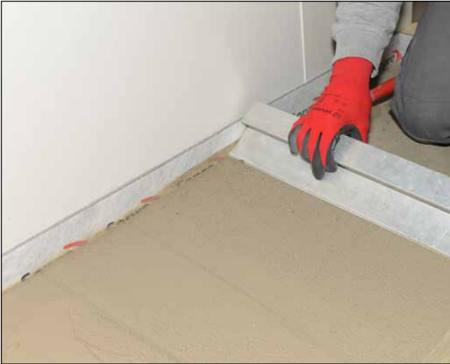
5 Herstellen eines Gefälles durch Abziehen mit der Latte.
