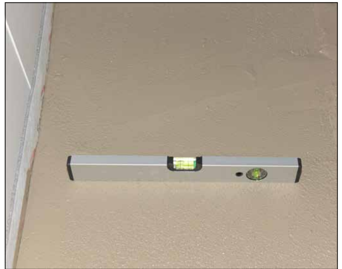
8 Eingebautes Gefälle mit Neigung zum Ablauf.
