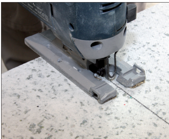
11 Für das Zuschneiden der Sopro FliesenDämmPlatte ist z. B. eine Stichsäge zu verwenden.
