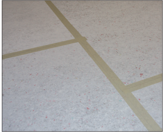
14 Zur Vermeidung von Mörtelbrücken (Körperschallbrücken) werden die Stöße der Platten mit Kleband überklebt.
