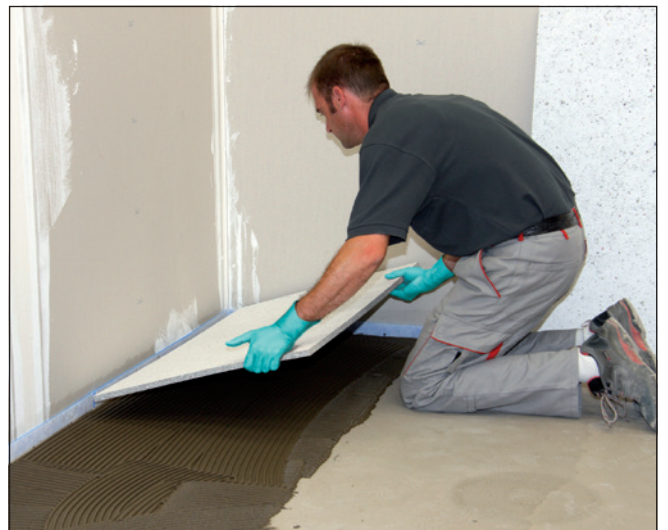
10 Das Einlegen der Sopro FliesenDämmPlatte erfolgt vollsatt in das frische Mörtelbett.
