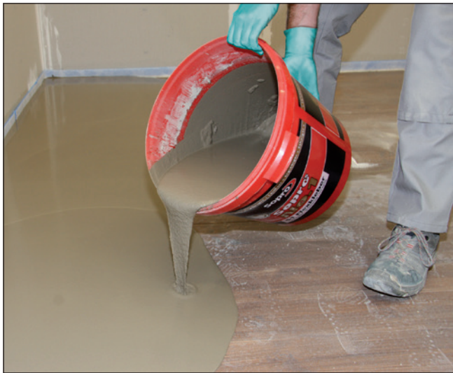
7 Der selbstnivellierende, fasermierte und flexible Sopro FaserFließspachtel wird im direkten Kontakt zum Holzdielenboden aufgebracht.
