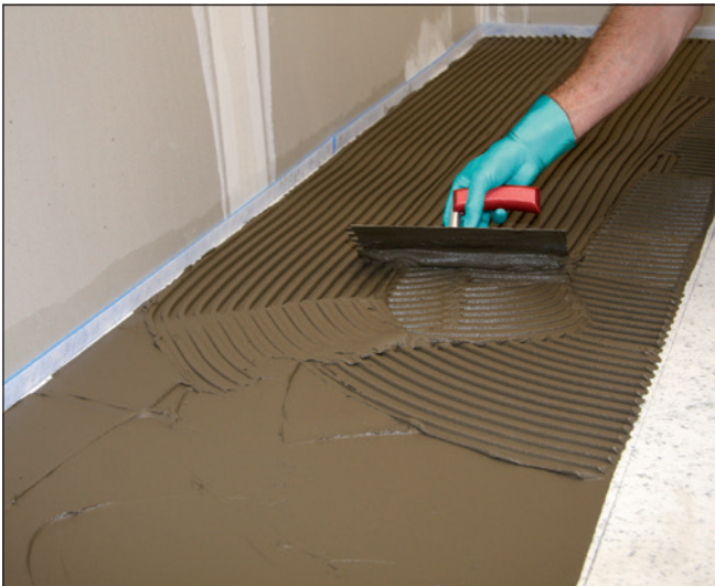
15 Auftrag von z.B. Sopro's No. 1 Flexkleber mit einer Zahnkelle auf die Sopro FliesenDämmplatte für die anschließende Verlegung des keramischen Belages.
