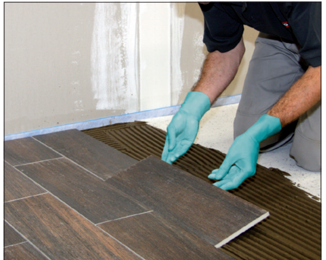
16 Verlegen der keramischen Fliesen in das vorbereitete frische Mörtelbett.
