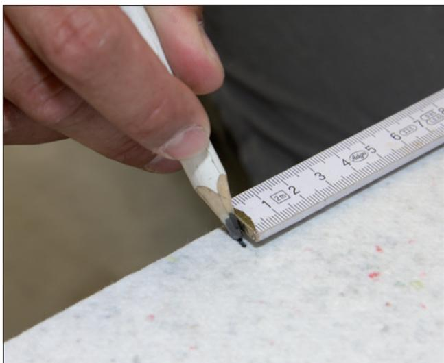
**3** Anriss zum maßgenauen Schneiden einer Sopro FliesenDämmplatte.
