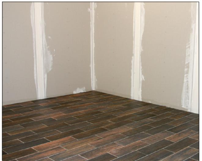
**18** Entkoppelter, frisch verlegter und verfugter keramischer Belag auf einem Holzuntergrund.
