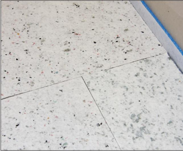
**13** Plattenstöße nebeneinanderliegender Reihen werden versetzt verlegt.
