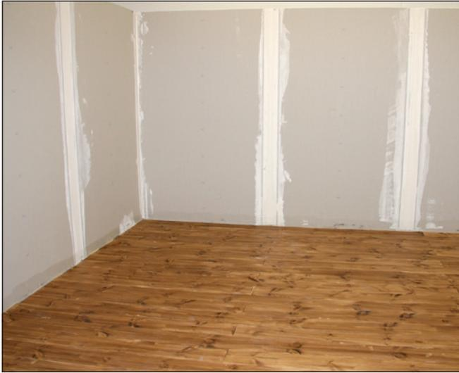
**1** Holzdielenboden, der im Rahmen einer Sanierung mit einem keramischen Belag belegt werden soll.
