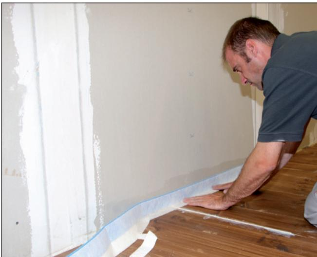
**5** Zu allen aufgehenden Bauteilen (Wände) sind Randdämmstreifen, z.B. Sopro RandDämmStreifen, anzuordnen.
