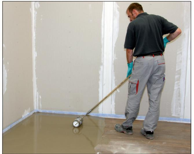
**8** Mit einer Stachelwalze wird die aufgebraute Spachtelmasse verteilt und verdichtet, um eine planebene Oberfläche zu erhalten.
