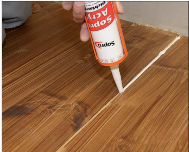
**4** Damit die selbstverlaufende Spachtelmasse für die Ausgleichsarbeiten nicht in die Fugen zwischen den Holzdielen einläuft, sind die Fugen mit Sopro Dichtacryl zu schließen.
