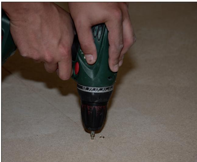
**1** Vor der Verlegung der Sopro FliesenDämmplatte auf z.B. Spanplatten, sind die Spanplatten fest anzuschrauben.
