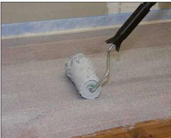
**5** Der Holzuntergrund ist mit dem Sopro HaftPrimer S als Haftvermittler zu grundieren.
