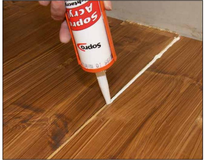
**2** Fugen und Löcher sind mit Sopro Dichtacryl zu verschließen.
