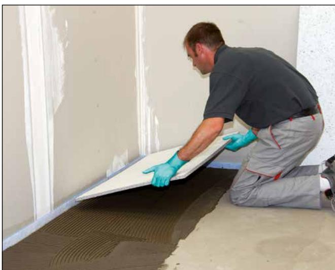
**11** Eine Verlegung der Sopro FliesenDämmplatte mit einem Sopro Flexkleber (z.B. Sopro's No.1) zum Auffangen von Bewegungen aus dem Untergrund ist im Anschluss dringend zu empfehlen.
