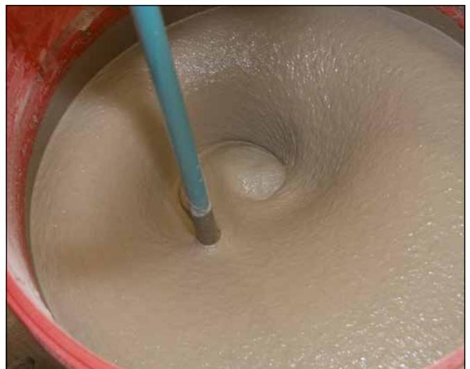
**6** Der selbstnivellierende Sopro FaserFließSpachtel ist mit einem Rührquirl zu einer homogenen, klumenfreien Masse anzurühren ...
