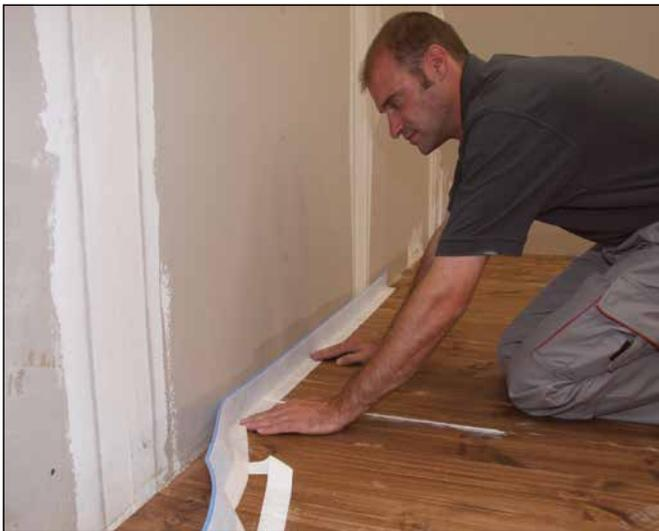
**3** Um ein Hinterlaufen der Spachtelmassen zu verhindern, ist der selbstklebende Sopro RandDämmstreifen aufzustellen.
