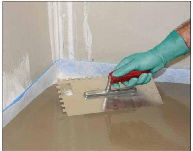
**8** Mit einer Glättkelle oder einem Raker kann der Sopro FaserFließspachtel gleichmäßig verteilt werden.
