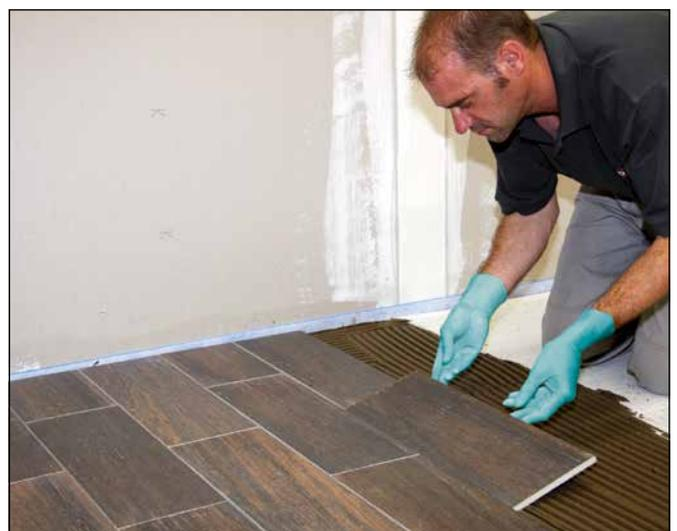
**12** Aufziehen eines Sopro Flexklebers (z.B. Sopro's No.1) und anschließendes Einlegen der Fliesen.
