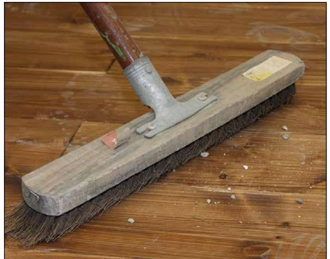
**4** Die Fläche ist vor dem Auftrag des Sopro Haftvermittlers ausreichend von haftungsminderten Stoffen (z. B. Staub) zu befreien.
