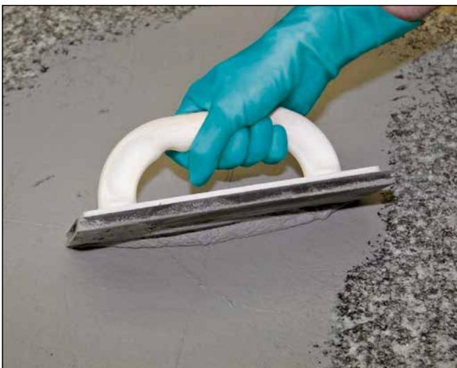
**5** Verfugung des verlegten Natursteinbelages mit einer Sopro Fugenmasse (z. B. Sopro DF 10® DesignFuge Flex).
