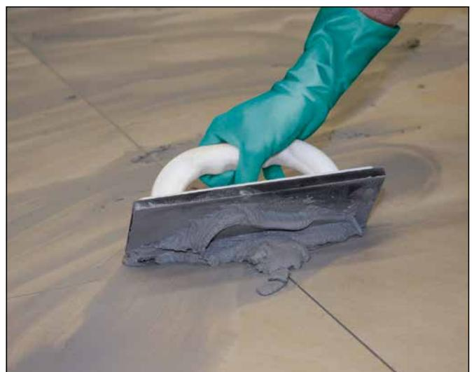
**6** Verfugung mit einer Sopro Fugenmasse (z. B. Sopro DF 10® Design-Fuge Flex oder Sopro FlexFuge FL) und anschließendes Abwaschen der Fläche.
