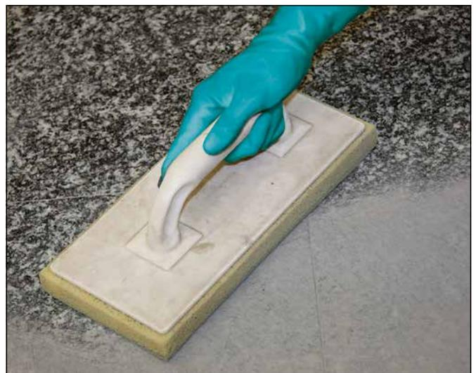
**6** Abwaschen des Natursteinbelags nach ausreichender Standzeit der eingefügten Sopro Fugenmasse.
