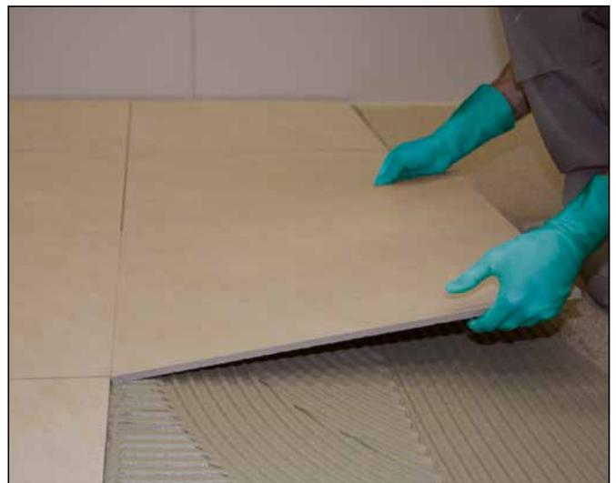
**4** Großformatiges Feinsteinzeug einlegen und ausrichten.
