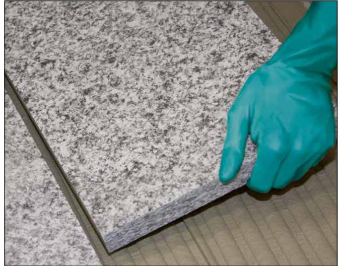
**2** Natursteinplatten einlegen und ausrichten.
