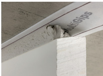
Randanschlussstreifen werden direkt nach dem Wandaufbau bzw. nach einer geforderten ganzflächigen Verspachtelung flächenbündig gekürzt.
