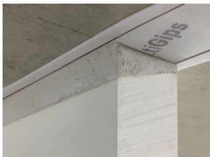
Randanschlussstreifen werden direkt nach dem Wandaufbau bzw. nach einer geforderten ganzflächigen Verspachtelung flächenbündig gekürzt.
