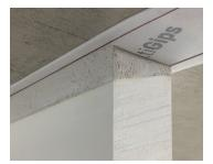
Nur das vollständige Füllen der Deckenanschlussfuge gewährleistet die statischen sowie die schall- und brandschutztechnischen Eigenschaften des Bauteils aus Gips-Wandbauplatten
