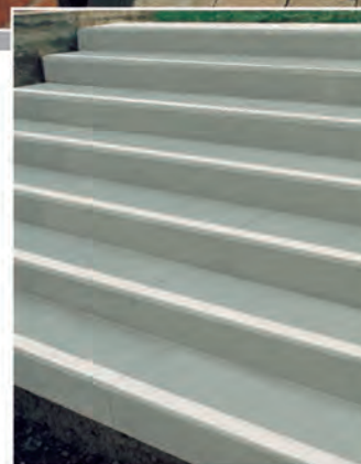
◀ Blockstufen als Stufenanlage verlegt. (mehrere Stufen nebeneinander, an den Stößen entsteht eine Keilfuge).
