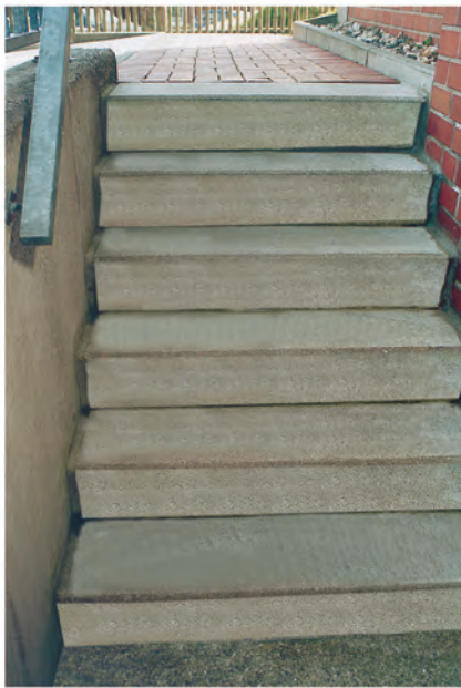
Kellertreppe mit bauseitigem Podest aus Pflastersteinen und Fortführung im Gelände
