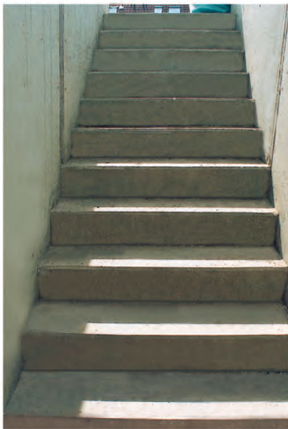
Kellertreppe eingebaut in zwei seitlichen Betonwänden
