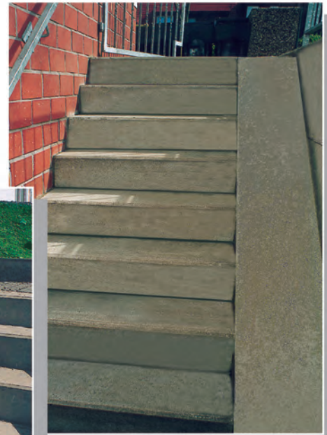
Kellertreppe mit bauseitiger gegossener Rampe
