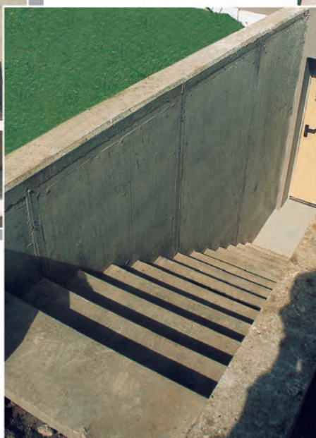
Kellertreppe eingebaut in zwei seitlichen Betonwänden
