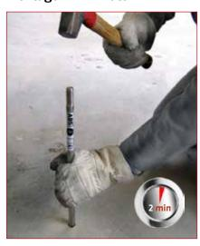
Die Montage des ABS-Lock® III-BE ist denkbar einfach und sicher - Sie bohren ein Ø16mm (5/8") Loch in den Beton. Dann nehmen Sie den Anschlagpunkt in die Hand, stecken ihn in das Bohrloch und schlagen ihn mit einem Hammer ein.
