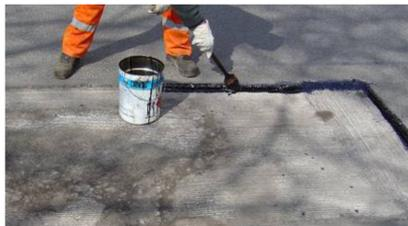
Für den Voranstrich muss ein Prüfzeugnis gemäß den TL/TP Fug StB vorliegen. Für das TOK®-Band spezial wurde der bitumenhaltige Voranstrich CORRISOL® Spezial (Farbe schwarz) entwickelt. Im Sommer beträgt die Abluftzeit lediglich ca. 10-20 Minuten.
