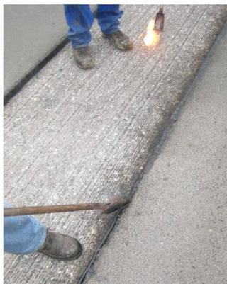
Vor dem Aufbringen wird das Fugenband mit dem Trennpapier nach oben ausgelegt. Das Trennpapier sollte erst unmittelbar vor der Verlegung entfernt werden. Das anschmelzbare TOK®-Band spezial wird mit dem Gasbrenner angeschmolzen und dann an die Fugenflanke angedrückt.
